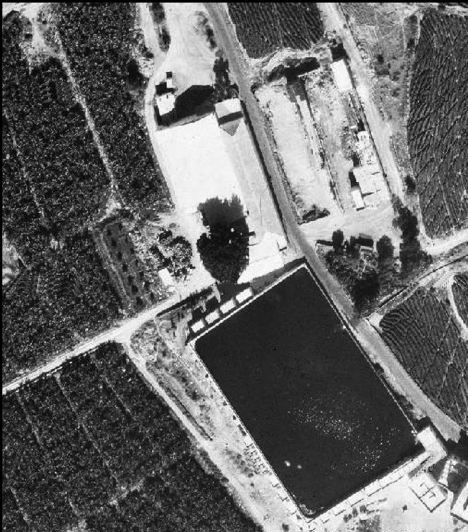
Nave de Fyffes. Vista aérea 1972
